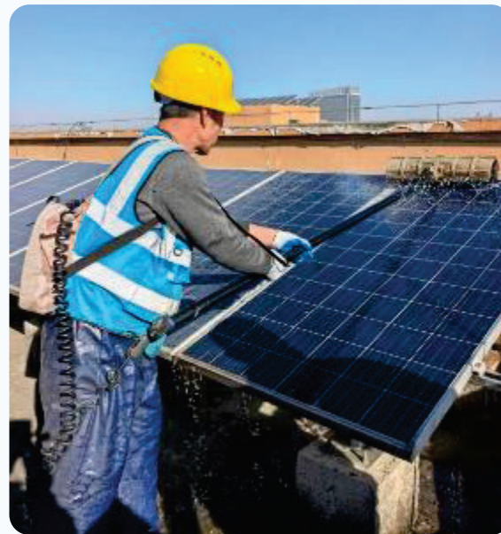
使用回收水源清洗光伏組件
