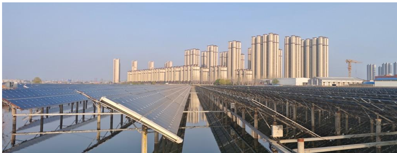
徐州光伏渔光互补发电示范项目
