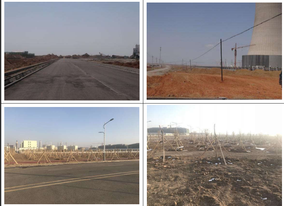
厂外道路区土地整治及绿化
