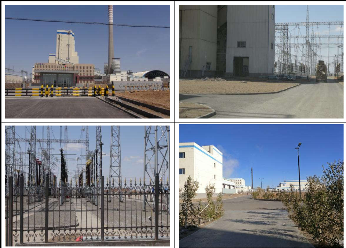
厂区土地整治、砾石压盖及绿化
