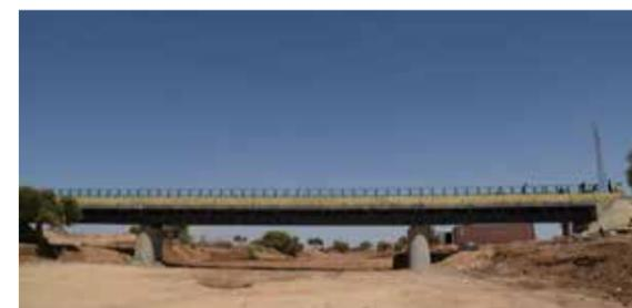
保利协鑫石油天然气集团在作业地区(dabowin)修建了一条长123公里、宽8米的道路，并完工修建了一座承载力80吨的钢结构混凝土桥梁，为社区生产、生活提供了巨大便利
